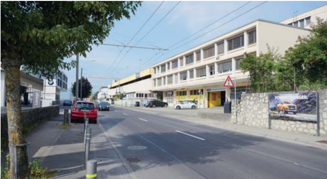
Une vue de l'avenue des Portes-Rouges. Une partie du «bâtiment Coop», à droite, sera démolie, une autre entièrement transformée. DAVID MARCHON
