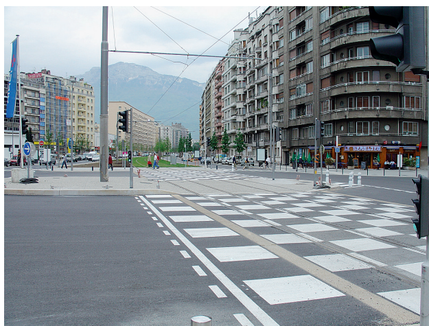
8: Place Gustave-Rivet après travaux (tram ligne C, Grenoble).
