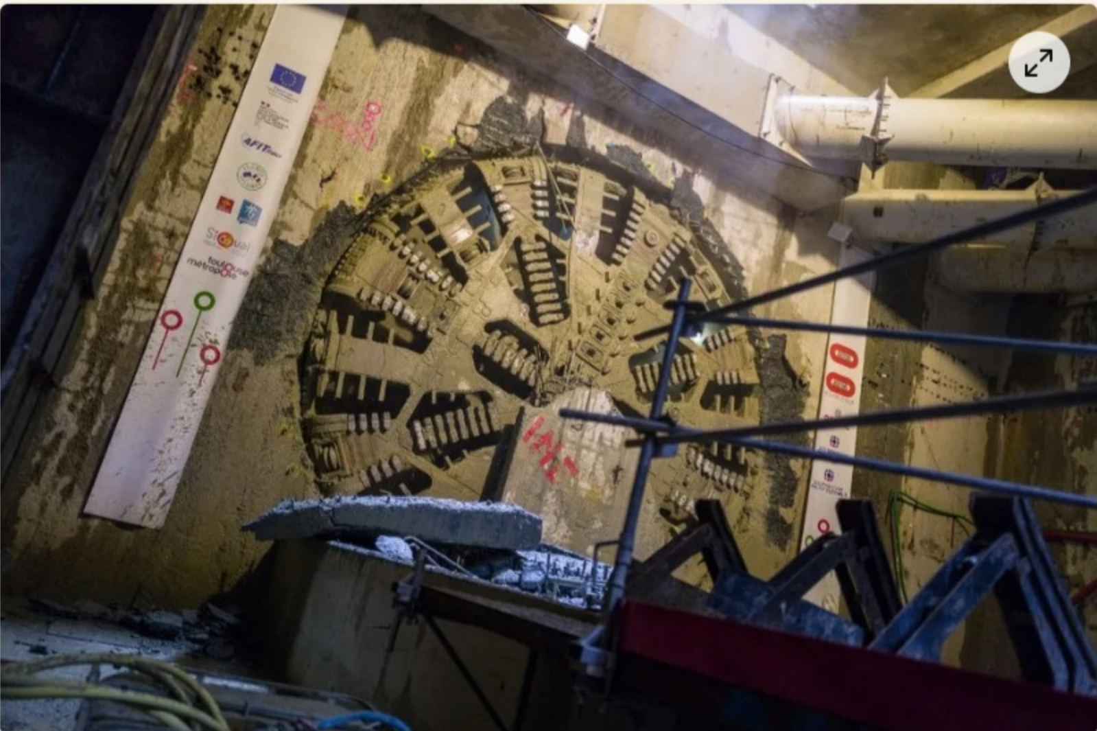
Quatre tunneliers creusent actuellement la future troisième ligne de métro à Toulouse. © FREDERIC SCHEIBER / HANS LUCAS
