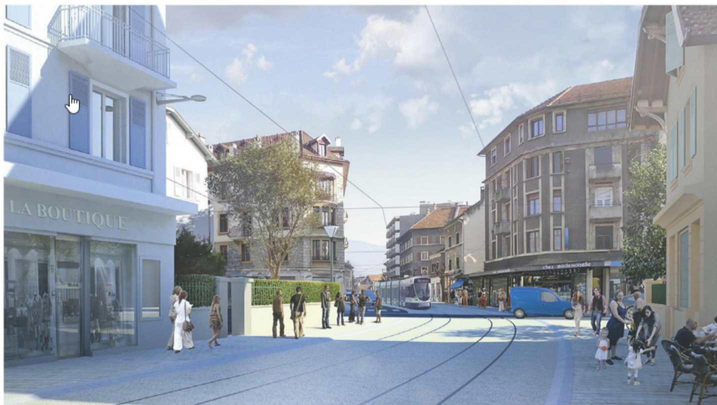
L'extension nécessite un budget de 50 M€ (ici, rue du Faucigny vers l'arrêt de la place Deffaugt).
