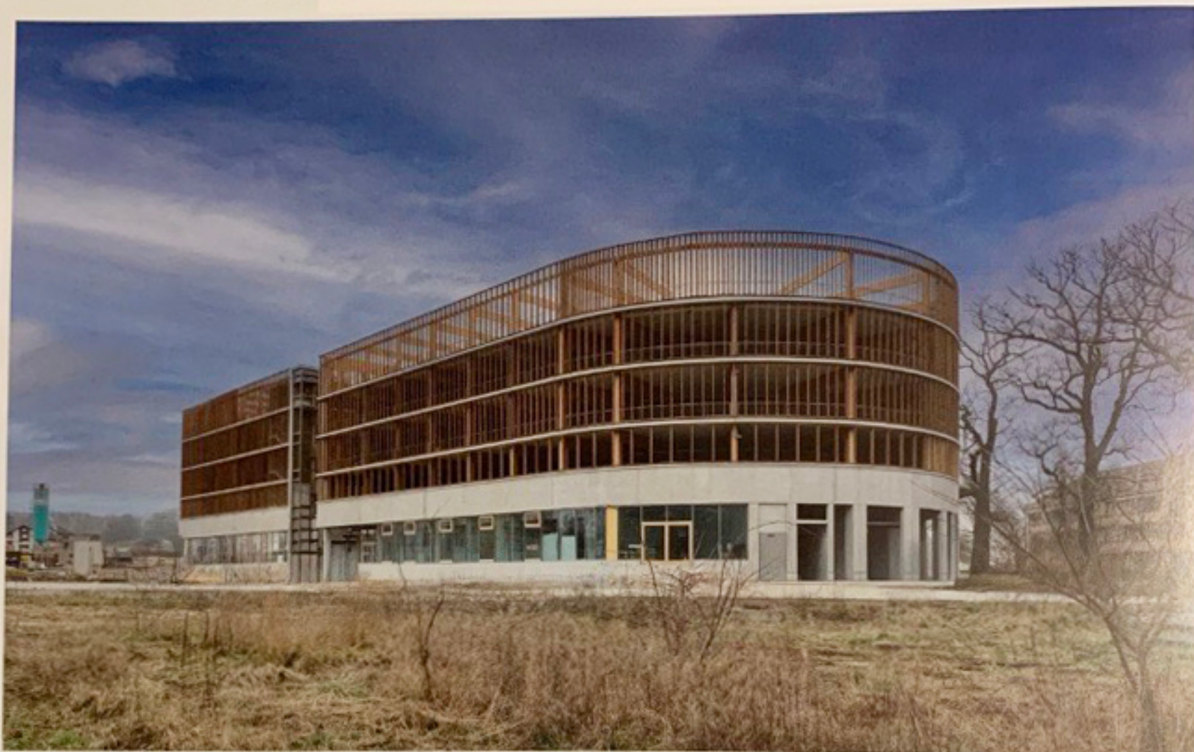
Le P+R Hotspot, à Ferney. Une opération commercialisée par la Fondation des parkings. Image : SPL Terrinnov
