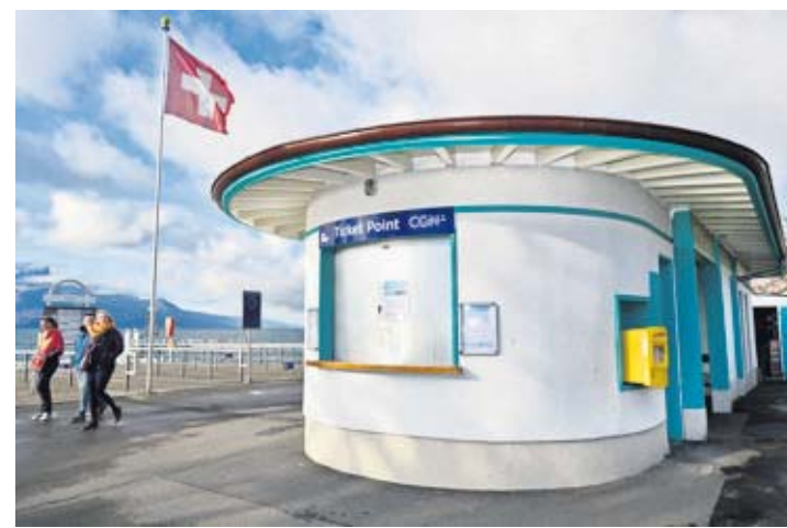
Le débarcadère a été entièrement restauré. CHANTAL DERVEY
