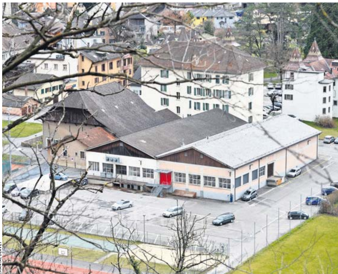
C'est dans la halle ouest des bâtiments de la Vinicole (à gauche) que la salle est prévue.
